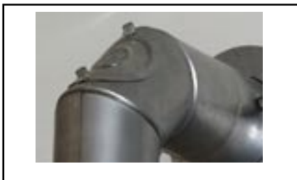
Rys.: Przyłącze rury spalinowej
