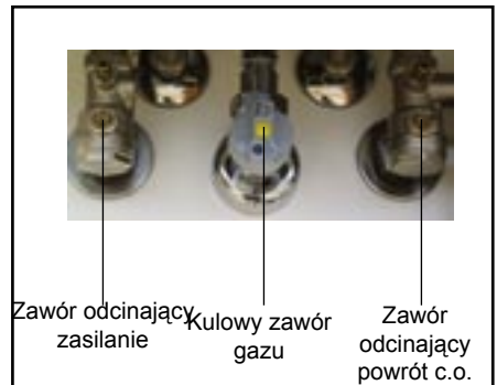
Rys.: Zawory odcinające
